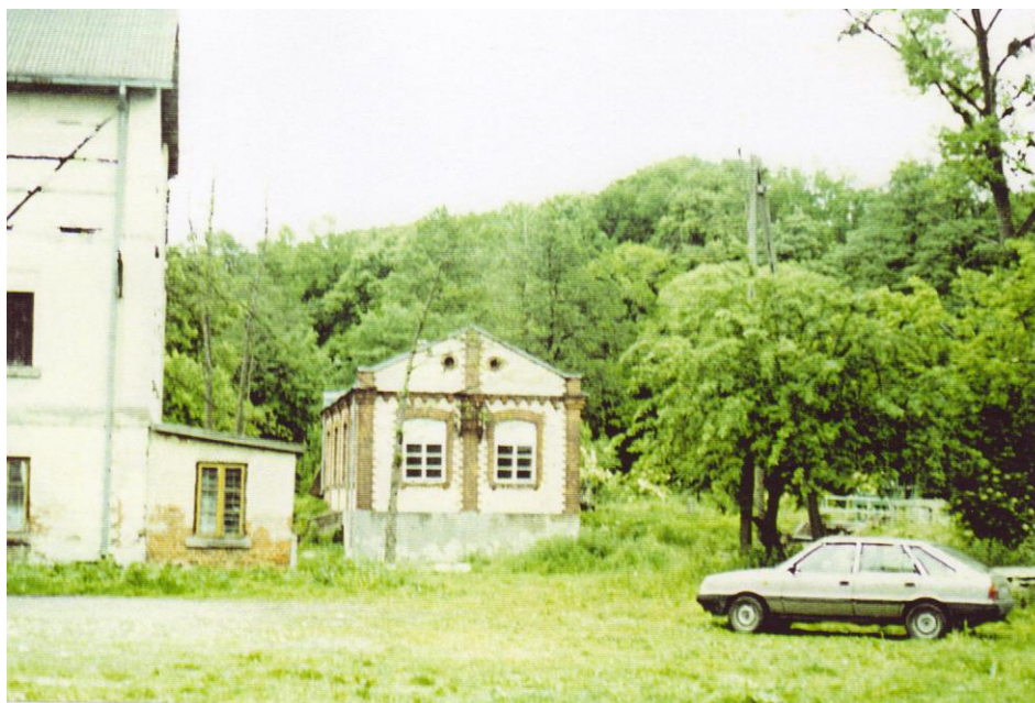
Elektrownia wodna 1913 r.
